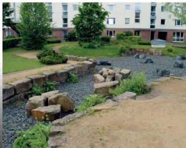
→ Abb. 11 Regenrückhaltefläche in einem Blockinnenhof
