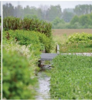
→ Abb. 45 Offene Ableitung von Niederschlagswasser
