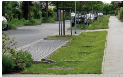
→ Abb. 22 Muldenkaskaden zur Versickerung von Straßenabflüssen
