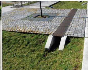
→ Abb. 23 Versickerungsflächen auf einem Platz
